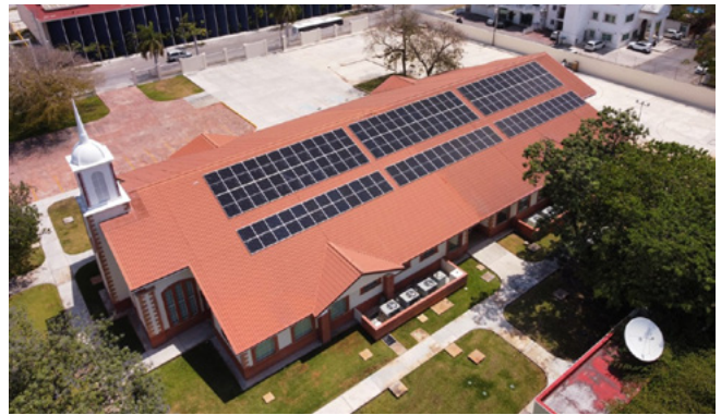
Un centro de reuniones de la Iglesia en Petén-Playa del Carmen, México, utiliza paneles solares para aprovechar la energía del sol.
