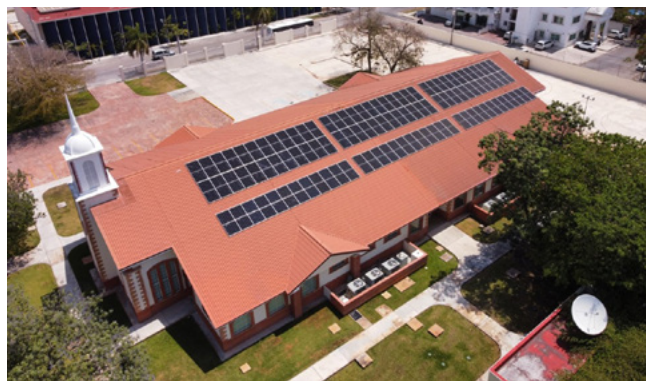
Una casa di riunione della Chiesa a Peten-Playa del Carmen, in Messico, usa pannelli solari per sfruttare l'energia solare.
